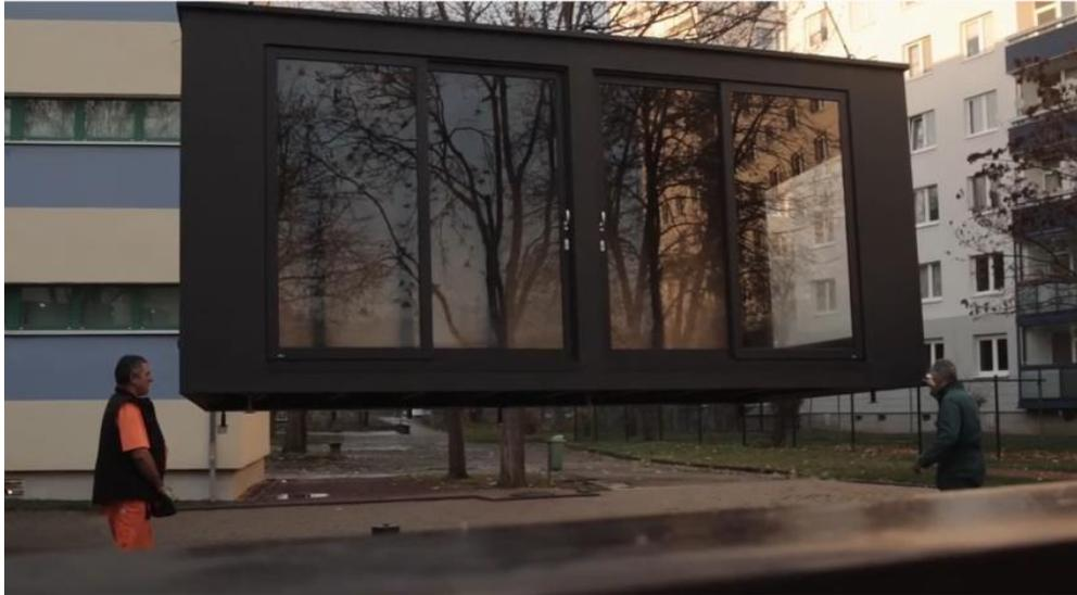
Das fliegende Klassenzimmer wurde vom Fraunhofer-Institut für Mikrostruktur von Werkstoffen und Systemen (IMWS) initiiert und ist ein innovativer Lernraum und Makerspace für Schüler\*innen. Es lässt sich mobil mittels eines Krans an verschiedenen Orten installieren und kann für Schulprojekte sowie außerschulische Projekte genutzt werden.
